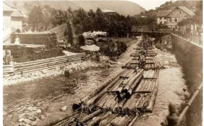
Mit Holzseilen, den Wieden, wurden die Flöße aneinandergebunden.
