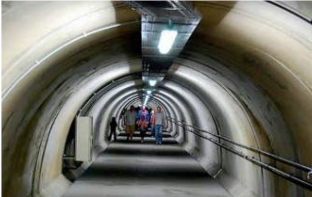
Blick in den Entnahmestollen
