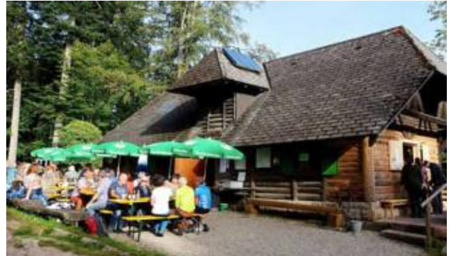
Gut zu erreichen: Auch eine Straße führt zur Kreuzsattelhütte, die am Westweg Pforzheim–Basel gelegen ist.
